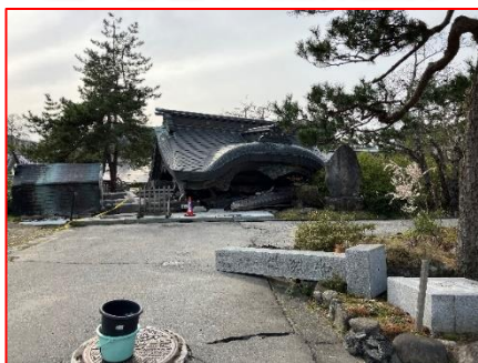
輪島市門前地区（大本山総持寺祖院境内）
