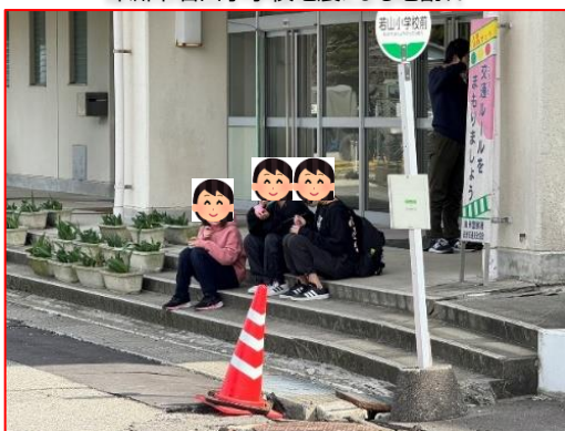
珠洲市若山小学校地震による地割れ
